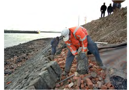
Een dijkenbouwer aan het werk
