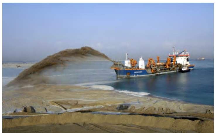
Een baggerschip aan het werk
